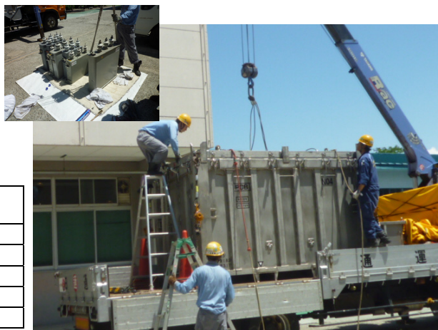
サクサ米沢事業場におけるPCB廃棄物搬出
