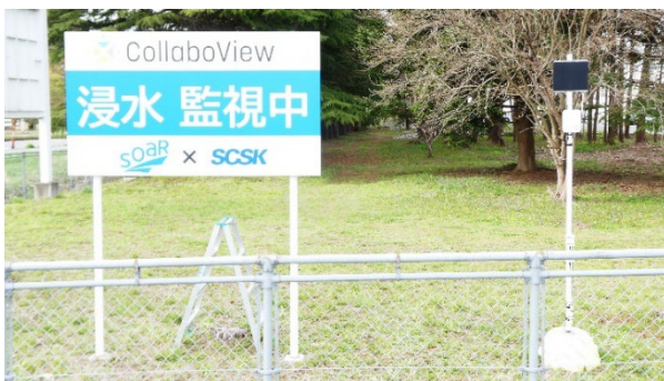
ワンコイン浸水センサの設置状況および立て看板
